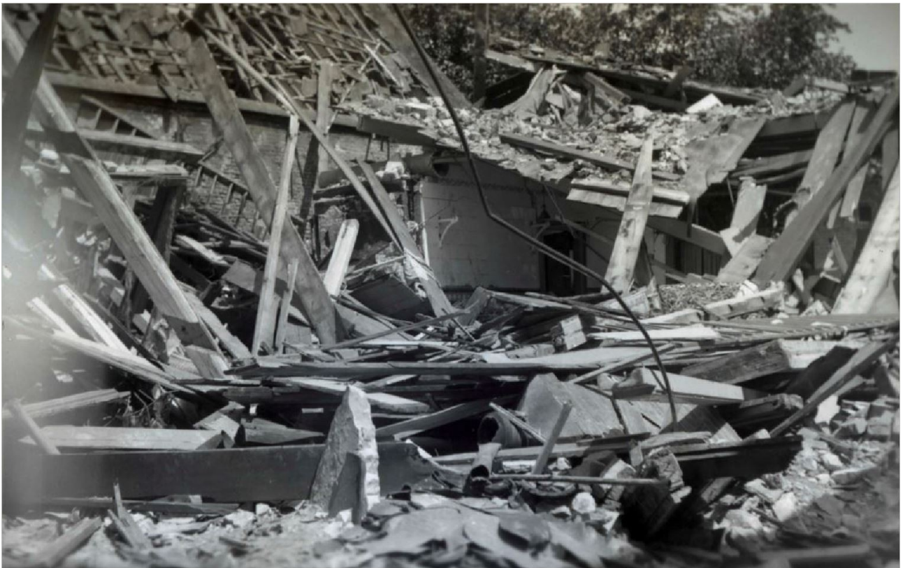
1940-05. Achterzijde slagerij v. Nugteren na het bombardement van Numansdorp op de morgen van Pinksterzondag 1940.
