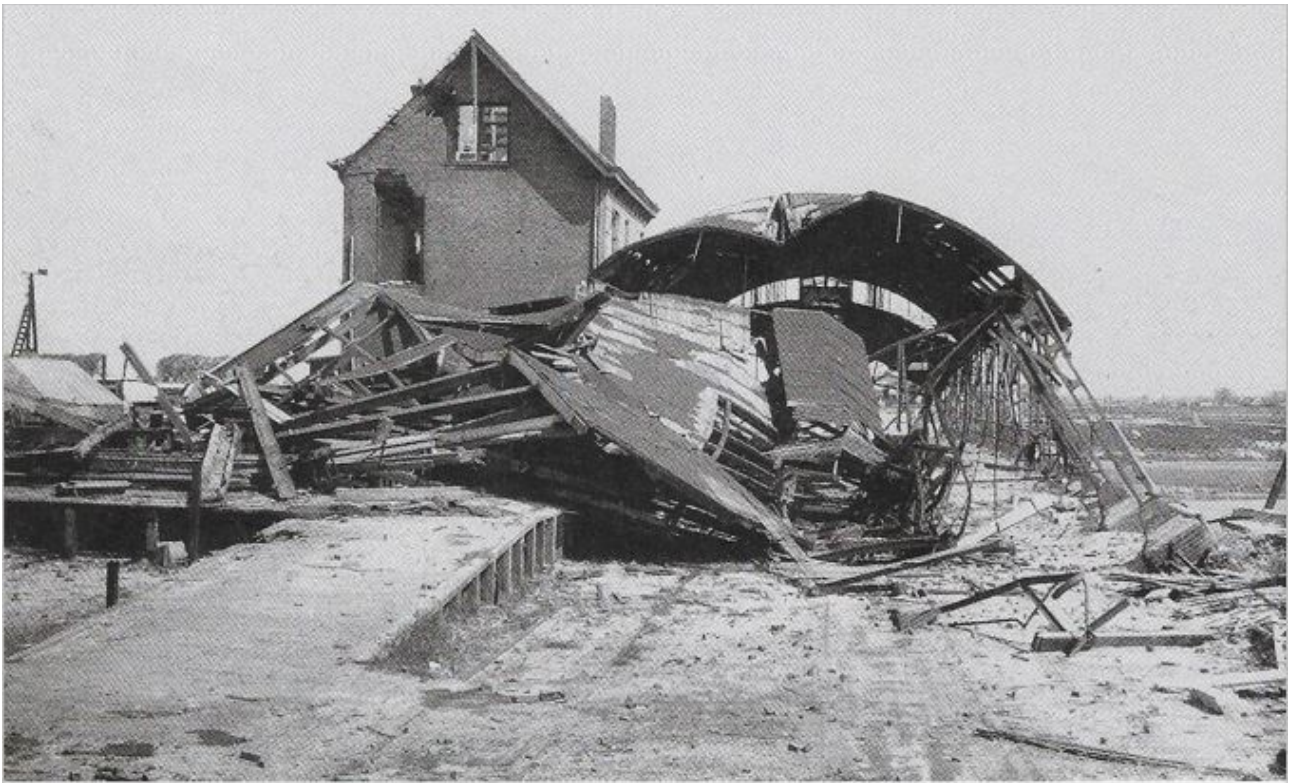
De schade aan het stationsgebouw na het bombardement. (Foto na de oorlog, Dhr. v Zuylen)
